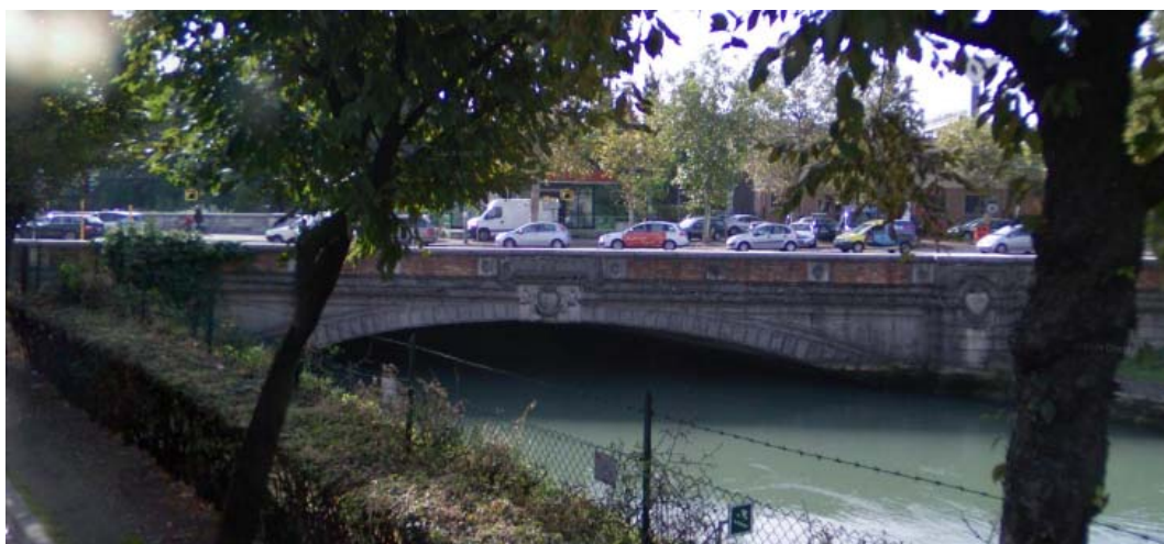
Figura 57 - Ponte sul Camuzzoni (Piazzale XXV Aprile)
